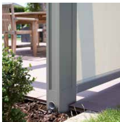
Integrovaný odvod vody
